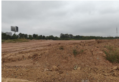
金洲大桥砂石归集项目回填场
