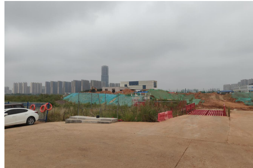
东城防涝泵站回填场
